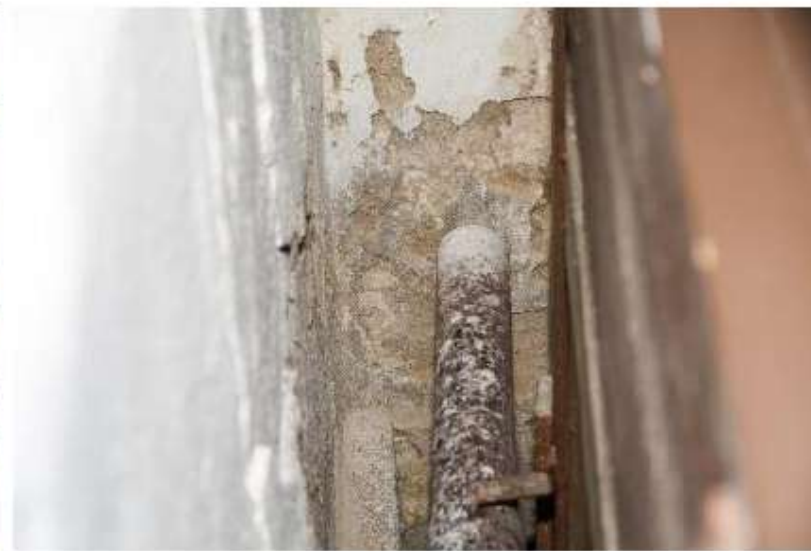
Tærede rørvne under stolestader ophængt i bæringer.
