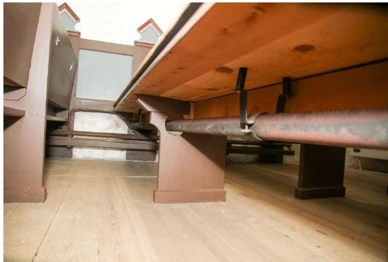
Tærede rørovne under stolestader ophængt i bæringer.
