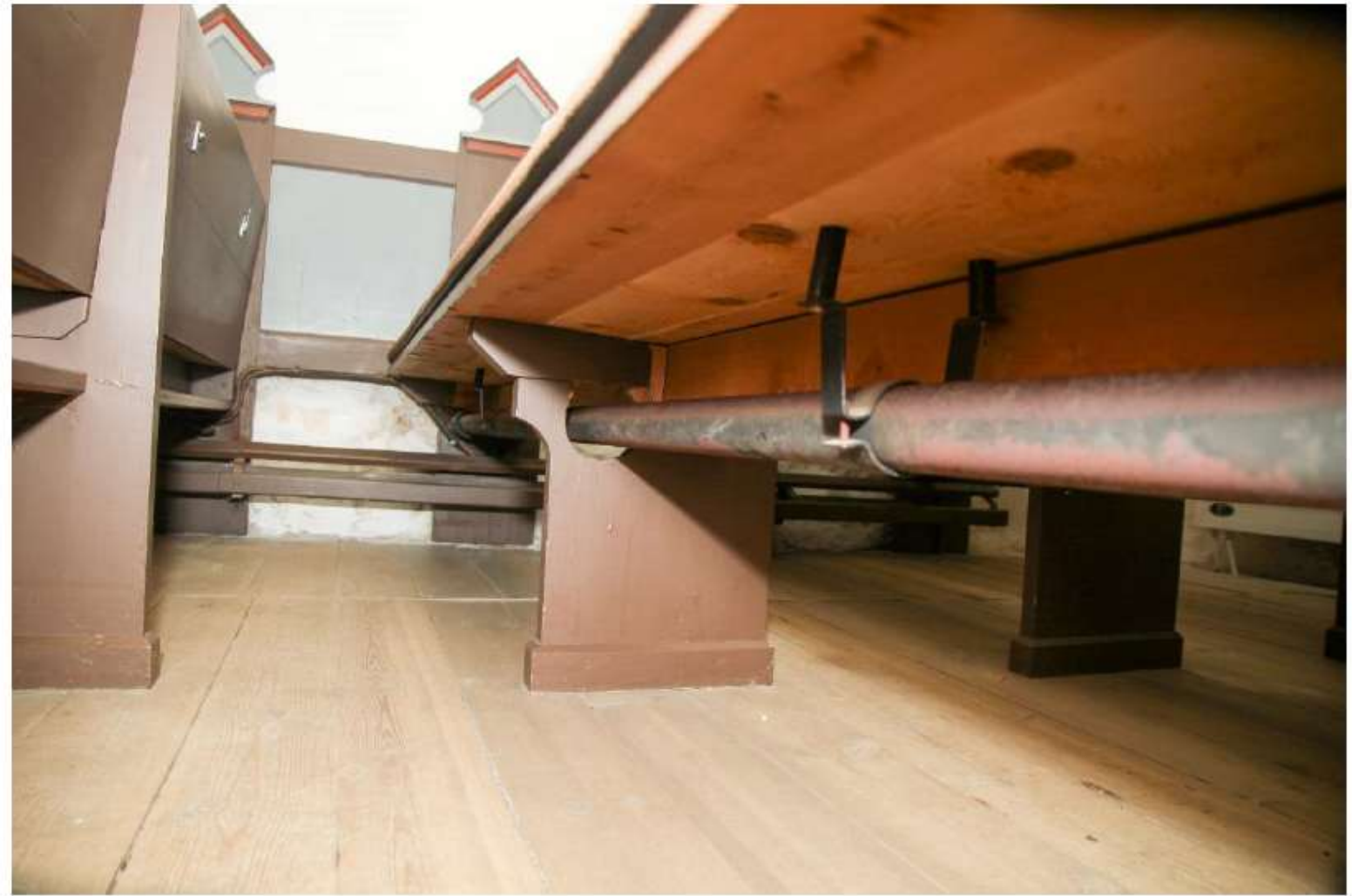
Tærede rørvne under stolestader ophængt i bæringer.
